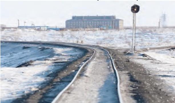
**Figura 1.13** La dilatación térmica puede deformar las vías del ferrocarril y ocasionar accidentes.
